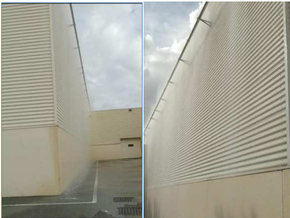
Essai rideau d'eau (ici sur extérieur mur coupe-feu)
